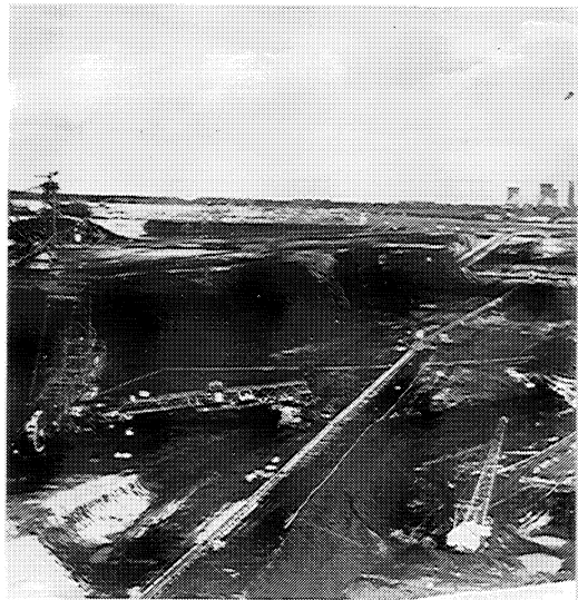
Abb. 1: RHEINBRAUN-Tagebauansicht mit Seilbagger vorne rechts
